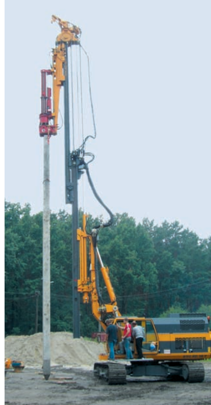
Rammen mit Hydraulikhammer Driving with hydraulic hammers
