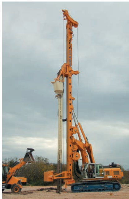
Tiefenrüttler-Verfahren Depth vibrator system
